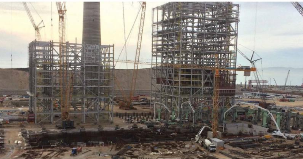
Karabiga kütle beton dökme işlemi
