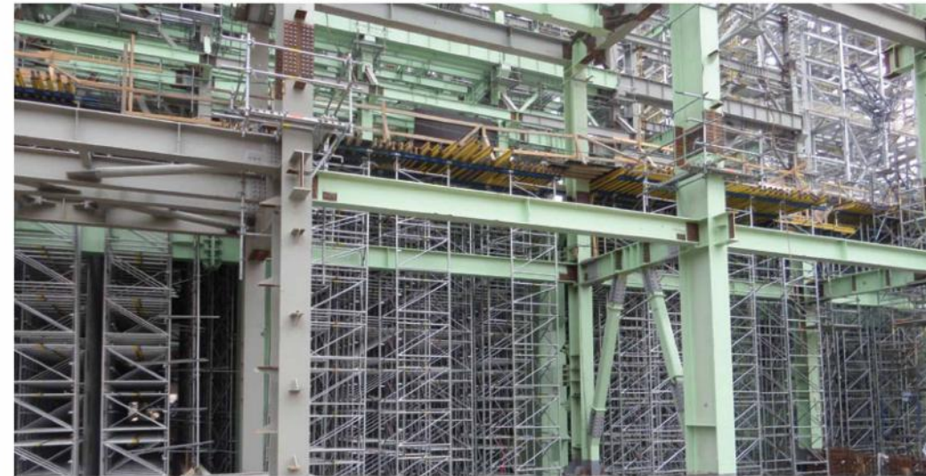
17 m yükseklikte 60 bin ton türbin temelinı taşıyan 18.000 m3 iskele kurulumu.
